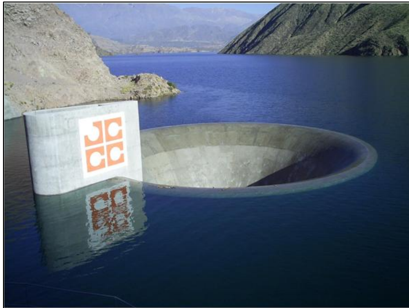
Fig. 1. Vista del Embalse Potrerillos y Vertedero.
