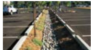
Trinchera de infiltración. Temecula, CA, USA.
